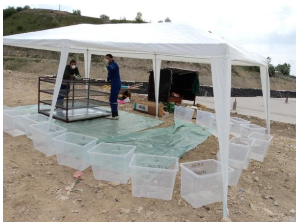
Slika 2: Lokacija na tijelu deponije za opremu korištenu u ispitivanju, primjerna regionalna deponija, Maj 2010
